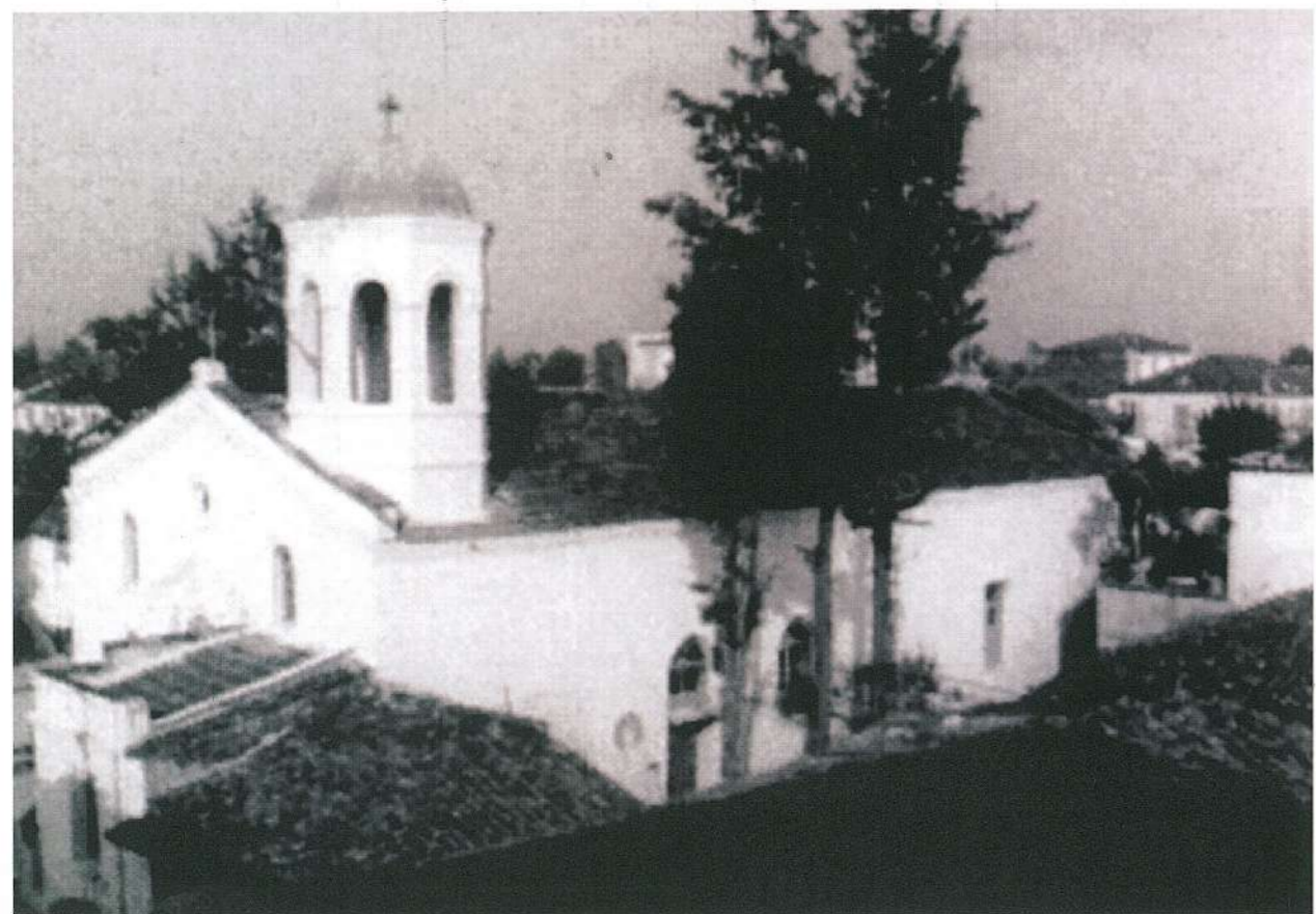
Ναός κοιμήσεως της θεοτόκου, δυτική και νότια άποψη
