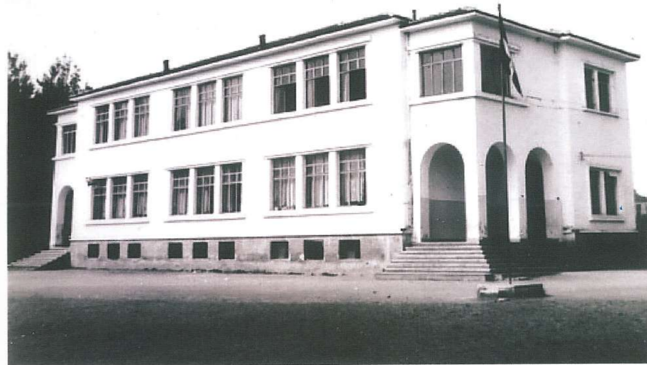
Β' Δημοτικό σχολείο
