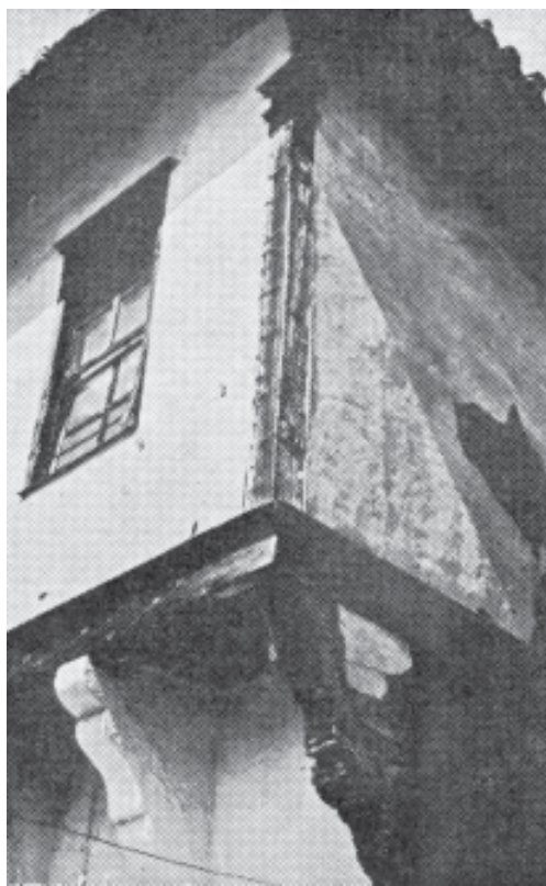
Εἰκ. 11. Ἐξωτερική γωνία τοῦ ἄνω ὀρόφου μέ ψευδοκιονίσκο
