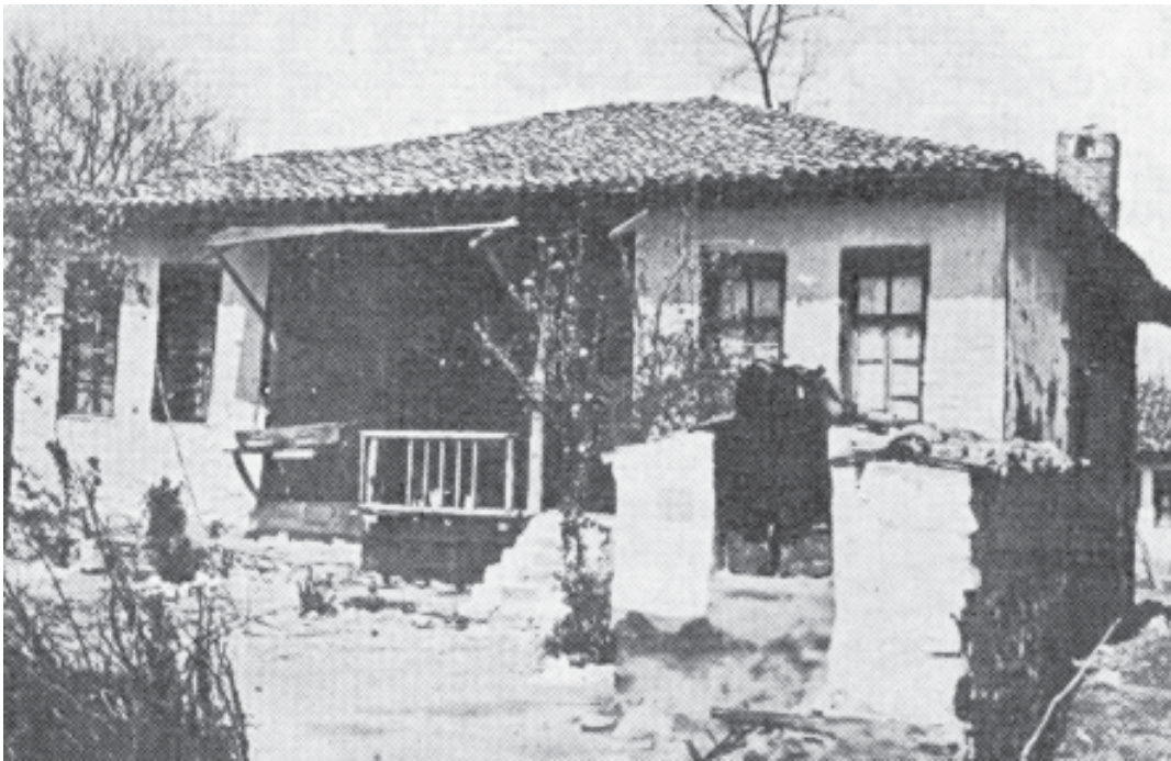
Είκ. 13. Σπίτι Στόγιου Μύρβαλη. Πρόσοψη
